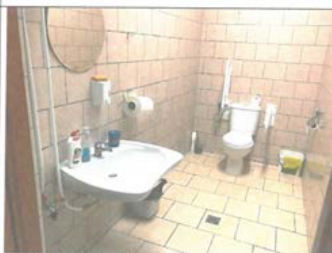
Fot.10. Toaleta dla osób niepełnosprawnych - dostosować wyposażenie toalety poprzez: zainstalowanie instalacji przyzywowej oraz montaż uchwytów w obrębie umywalki
