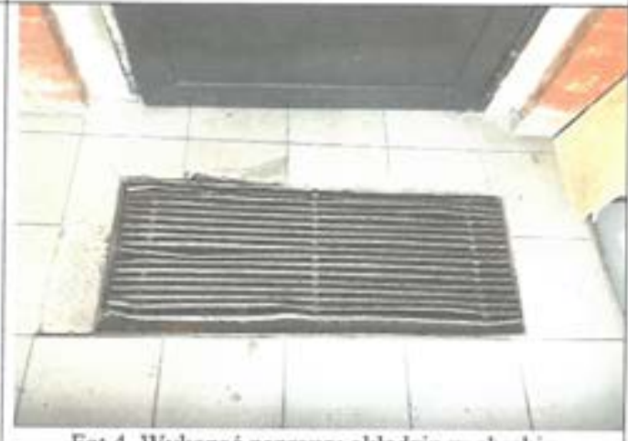
Fot.4. Wykonać naprawy okładzin w obrębie wycieraczki na klatce schodowej przynależnej do
