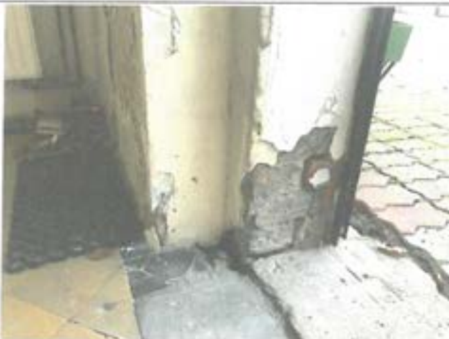
Fot.7. Odparzenia tynków na klatce schodowej od strony posterunku – zalecana naprawa ścian wraz z malowaniem
