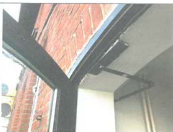
Fot.6. Uszkodzony samozamykacz drzwi wejściowych do klatki wejściowej od strony posterunku - zalecana naprawa lub wymiana
