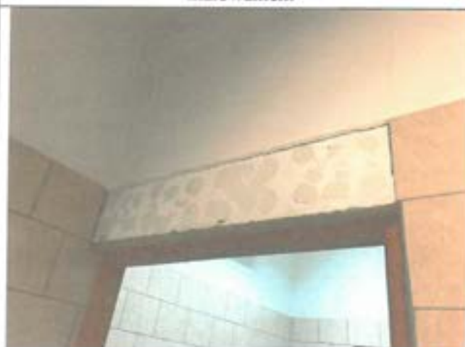
Fot.7. Odparzenia tynków na klatce schodowej od strony posterunku – zalecana naprawa ścian wraz z malowaniem
