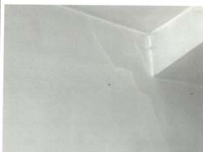
Fot.16. Miejscowe pęknięcia tynków na ścianach klatki schodowej w części po byłej szkole
