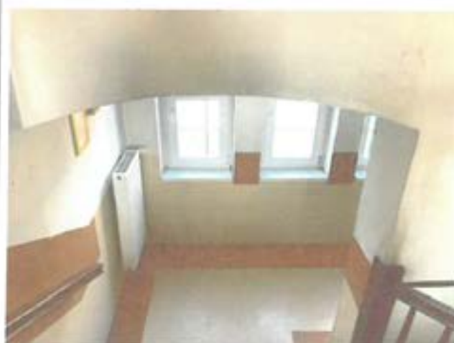
Fot.13. Widoczne zabrudzenia ścian na klatce schodowej w części po byłej szkole – zalecane malowanie ścian
