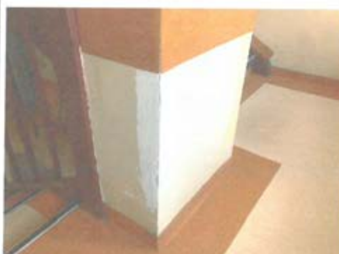
Fot.14. Wykonać naprawy i malowania tynków na klatce schodowej w części po byłej szkole
